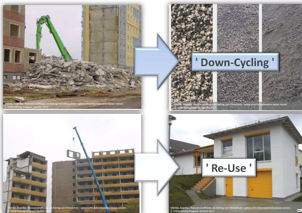
Abb. 2: Beispiel für die Bandbreite des Gebäuderückbaus 1
